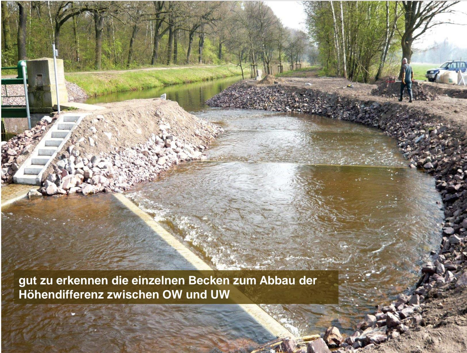
gut zu erkennen die einzelnen Becken zum Abbau der Höhendifferenz zwischen OW und UW
