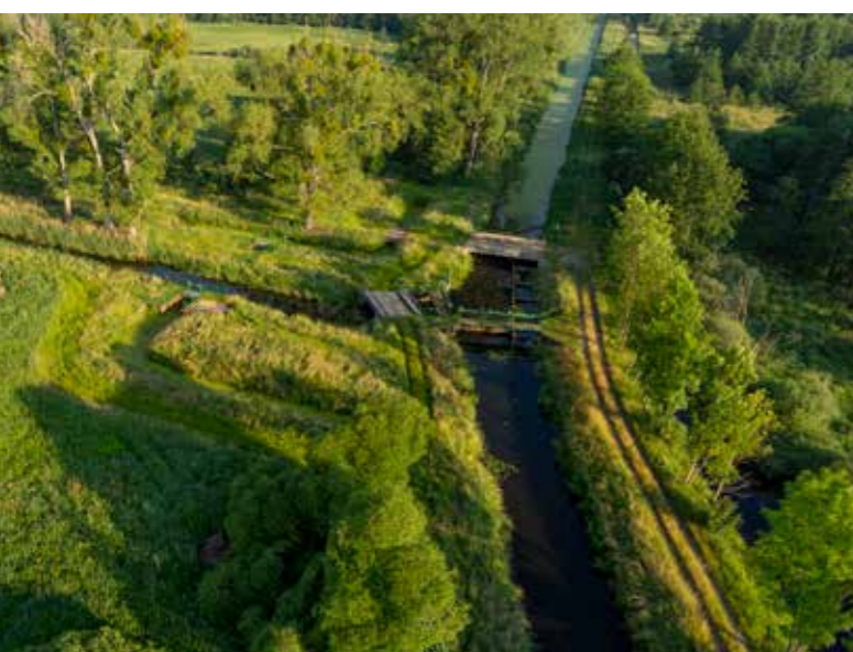
Abb. 11: Verteilerbauwerk im Drömling
